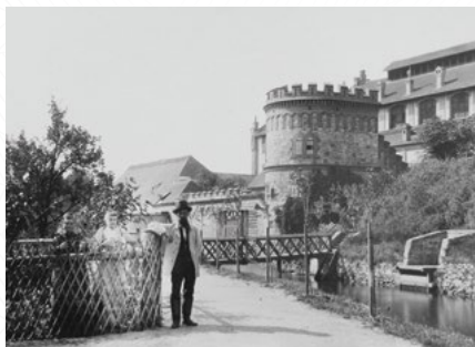
Část Zlaté stoky pod pivovarem v Třeboní. V pravé části je možné vidět filtr, přes který se odebírala voda ze stoky do pivovaru. Kolem roku 1890. (Fotografie z Alba fotografií města Třeboně, z pozůstalosti Jana Valíše zapůjčila rodina Pumprova)
