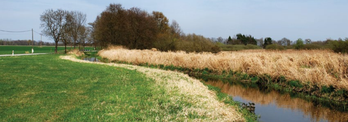
Hloubené koryto u Smržova
